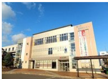
経済センター等 エレベータ修繕
