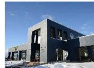
都市農村交流センター等 高圧受電設備等更新
