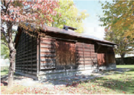
▲屯田兵屋の外観
