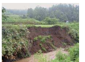
深川市内の災害における危険区域：市HP 河川の被災状況
