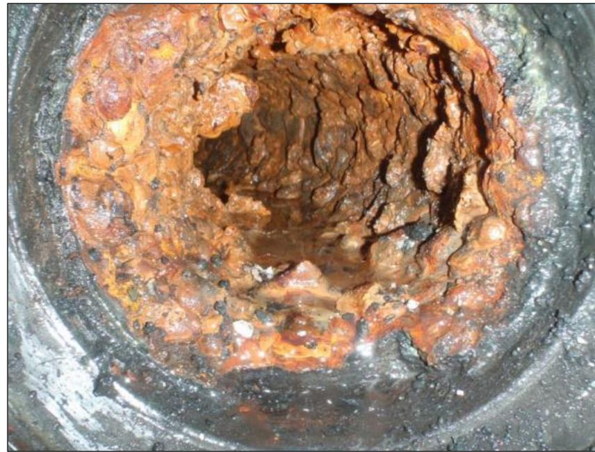
写真②:赤水の原因となる管路内の状況(鑄鉄管)
