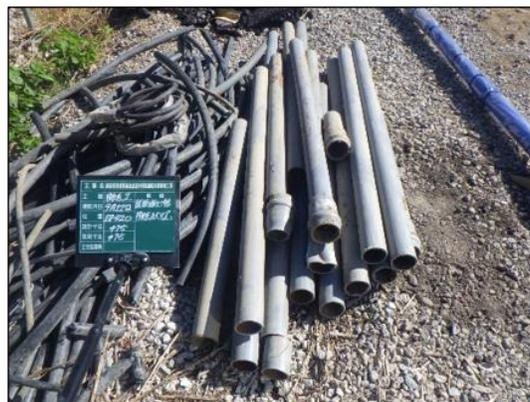
移設工事に伴う既設管撤去(塩ビ管)
