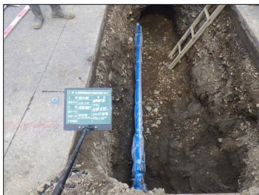
耐震管であるNS形E種管を採用(鋳鉄管)
