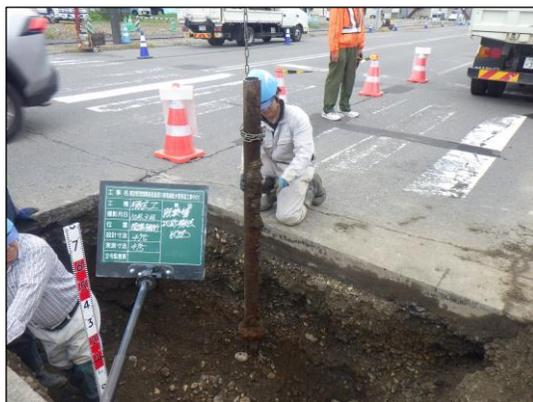
移設工事に伴う既設管撤去(鋳鉄管)
