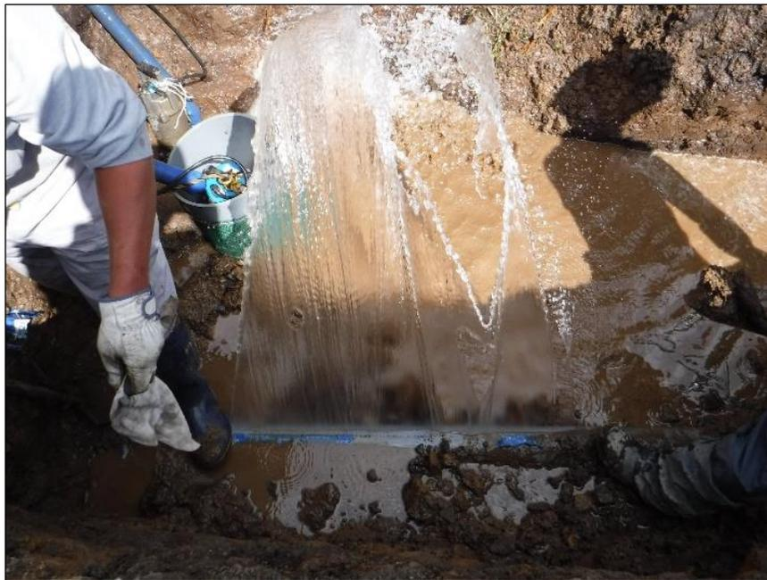
写真①:ひび割れによる漏水状況(塩ビ管)
