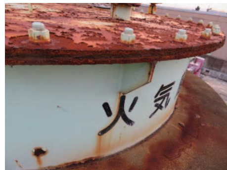
R6-R7 消化槽の更新
