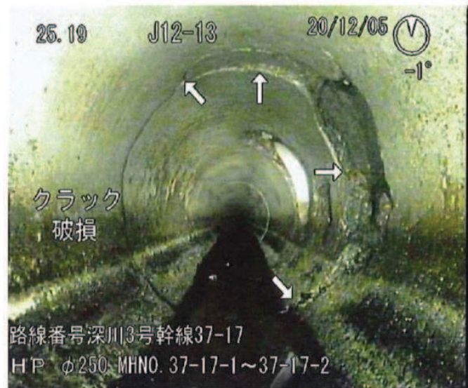
管渠カメラ調査画像
