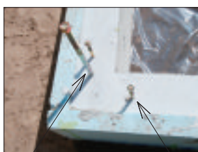
アンカーボルト — ホールダウン金物
