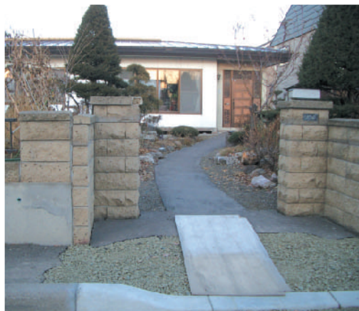
家の外周りは、もともと玄関から道路までの通路が緩やかな勾配でロードヒーティングとなっている。現在、縁石を低く手直し中
