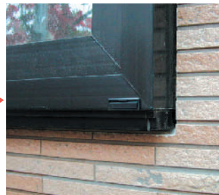
リフォーム後:断熱性の高いサッシに変更。窓下水切を取付ける
