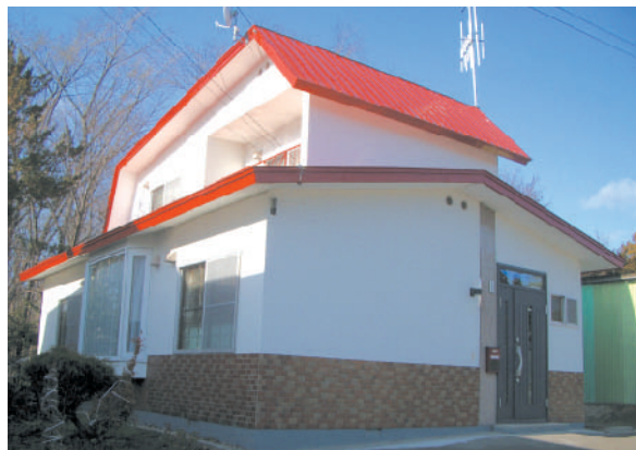
リフォーム後：外壁・屋根の全面塗装
