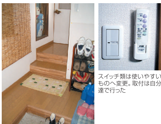
内玄関と階段は既存の間取りを活かし、床・壁を改修
