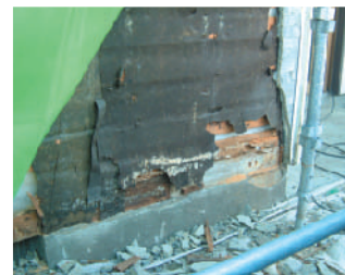
外壁:一度目のリフォームでモルタルの上に重ね張りしていた金属系サイディングと下のモルタル全てを撤去
