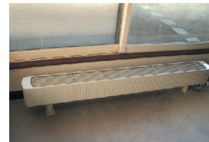
居間(南側面):パネルヒーターを設置 温度調節が自在になり快適
