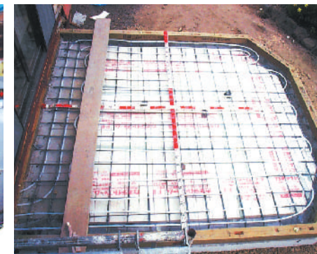
コンサバトリー工事の様子:床暖房
