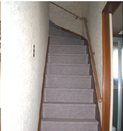
階段:老後に備え手すりを設置
