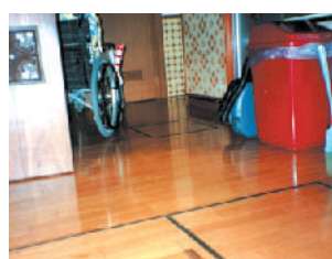
居間から台所、寝室、洗面所など、車いすですべてでも自由に移動できるよう床をフローリングに張り替え、段差を解消
