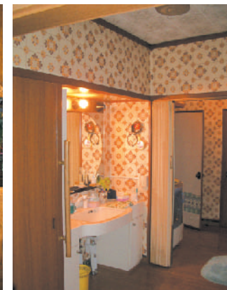
もともと水廻りが一体的にまとまっており、ゆつたりとしたスペースがとられていたため、間仕切りの変更は行わず、床の段差解消と洗面台などの変更を行った これまで、洗面台に車いすの足元が入らず、洗面器を利用し歯磨きなどを行っていたのが自分自身で行えるようになり、介護者側の負担も軽減された
