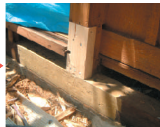
土台の腐食した部分を全て取り除き、新しい木材で補修
