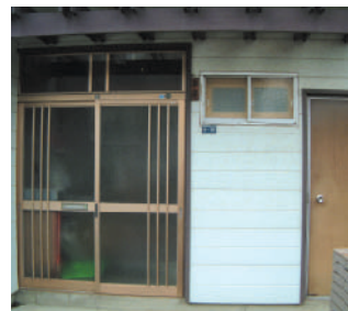
リフォーム前:玄関:窓同様、部屋が寒いという不満から玄関戸を変更
