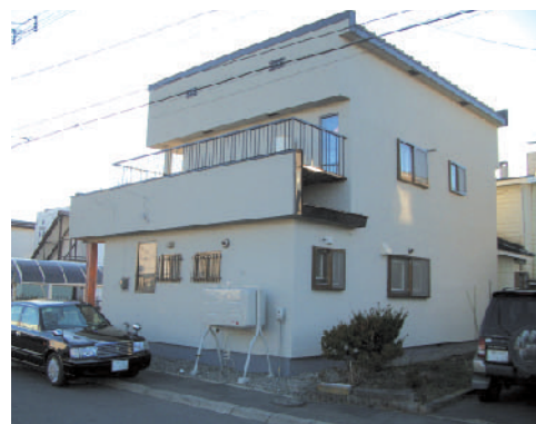
外壁の全面塗装:壁の色に灯油タンクと同色を選択し、一体的な雰囲気仕上げた 屋根:無落雪に変更
