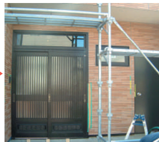
リフォーム後:断熱性の高いドアに変更。現在はさらに風除室を追加し、いっそう快適となった
