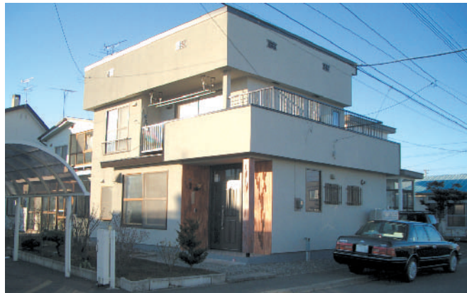
リフォーム後:外壁全面塗装、断熱性のある玄関ドアへ変更
