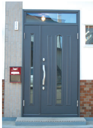
断熱性の高い玄関ドアへ変更
