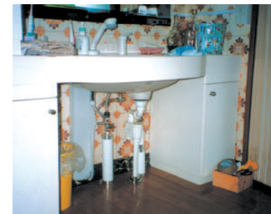
洗面台:足が洗面台の下に収まり、車いすに乗ったまま使用できるものへ変更
