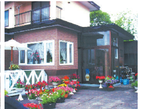
一階の外壁をサイディングに張り替え二階は既存のモルタル壁を塗り替え
