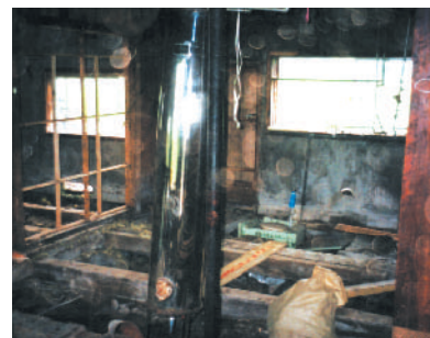
工事中:居間:基礎の老朽化が激しくコンクリートで密閉し補強
