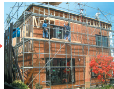
工事中:屋根の形状を変更する部分を増築。壁面には、耐震性を向上させる板材を使用
