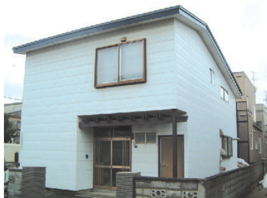
リフォーム前:金属系サイディングの外壁と落雪屋根
