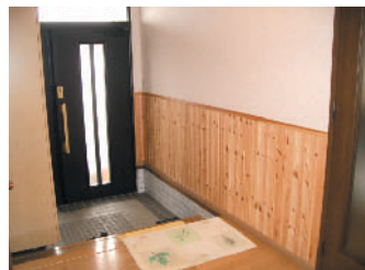
玄関工事後:クロスの張り替え 木の腰壁張り/断熱ドアに交換
