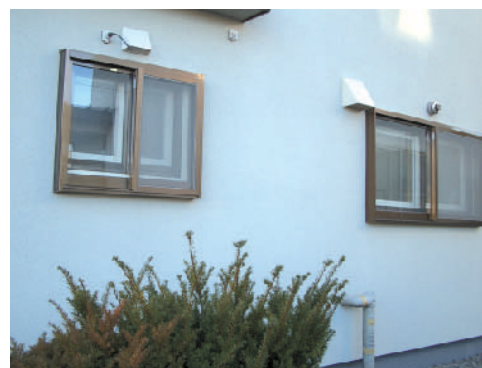
北側面の外壁:壁面の改修では、断熱性を高めるため、既存の窓を残し、もう一枚窓を重ね、三重の窓とした
