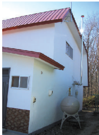
亀裂があり、倒壊が懸念されていた集合煙突を改修
