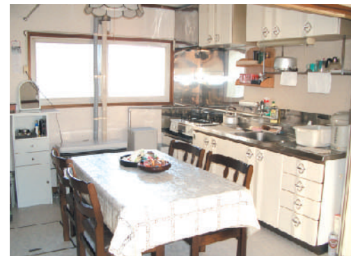
キッチン(北側):壁の改修に伴い、クロスの全面張り替え、システムキッチンの変更を行った。クロスや機器類は、色調を統一する点に気をつけ、部屋が明るくなる色を選択
