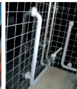
浴室に手すりを設置
