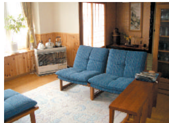
居間工事後:木の腰壁を張り、暖かい雰囲気
