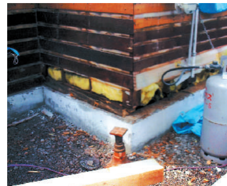
床組を組み替え、床の傾きを修正この改修で地震の被害が少なくなった
