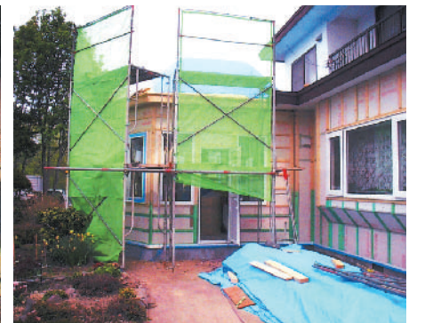
コンサバトリー工事の様子:外壁
