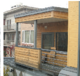
リフォーム後:居間からみた子供部屋(増築部分)
