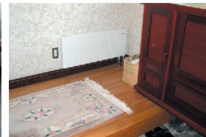
玄関:新たにパネルヒーターを設置
