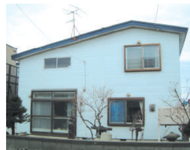
リフォーム前:屋根の雪が玄関先に落ち、危険を感じていたため無落雪屋根への変更を計画
