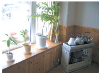
居間工事後:出窓力ウンターを木の腰壁と同素材で統一
