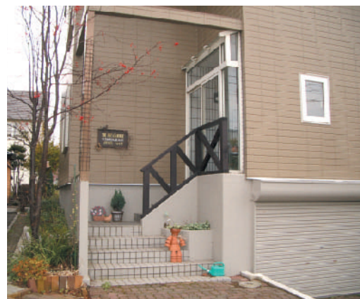
既存住宅部分:半地下タイプの地下車庫の存在により、玄関前には10段ほどの階段がある
