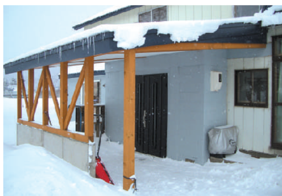
雪対策として玄関前に雁木を設置、玄関ブロックは自分達で塗装を行った
