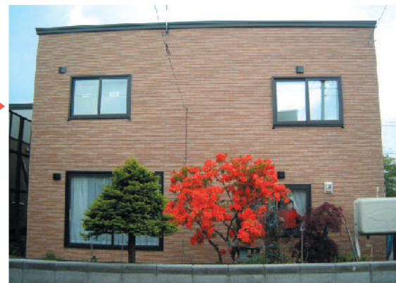
リフォーム後:玄関先の落雪に悩まされることがなく安心。また、屋根の形を変更したことで、小屋裏が広くなり活用している
