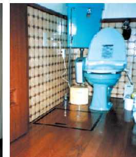
トイレ:床の段差解消
