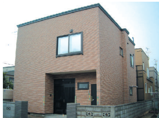
リフォーム後:外壁と無落雪屋根への改修
