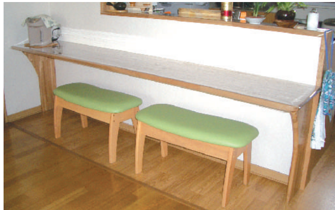
リフォーム後：ラーメンカウンター兼手すり
