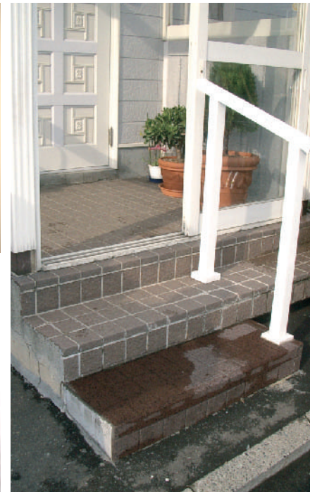
外玄関入り口前の段差が激しく、階段と接地面の間に1段追加し段差を和げるとともに、手すりを設置
