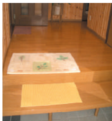
上がり框に式台を設置
