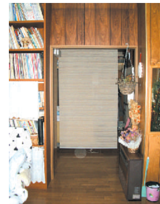
寝室と居間の壁を取り除き、空間を一体化、人が通れる部分を確認し、ロールカーテンを寝室の天井から設置したことで、居間からの空間が広く感じられる他、寝室で休んでいる際も人の出入りが気にならない
