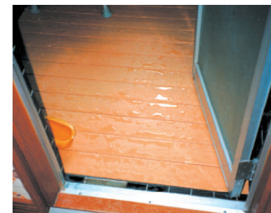
もともと浴室が広がったため、浴室の床にすのこを敷き段差を解消
