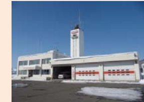
深川消防署幌加内支署 基地局1
