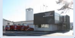
深川消防署秩父別支署
