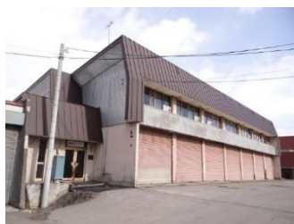
克雪車両センター
