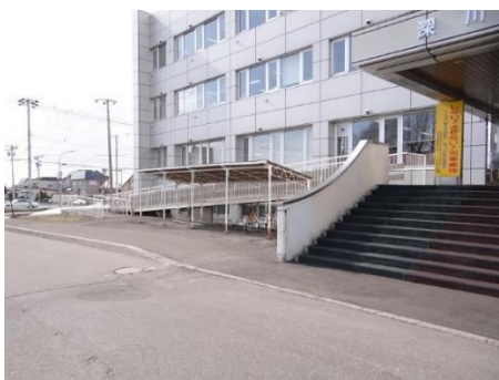
正面玄関階段と車いす用スロープ
