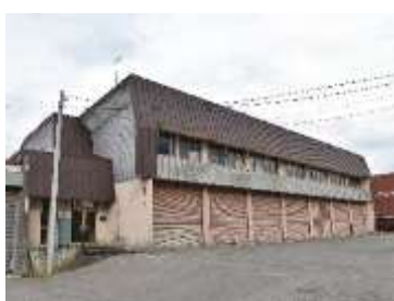
克雪車両センター
