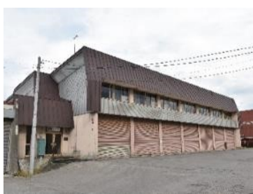
克雪車両センター
