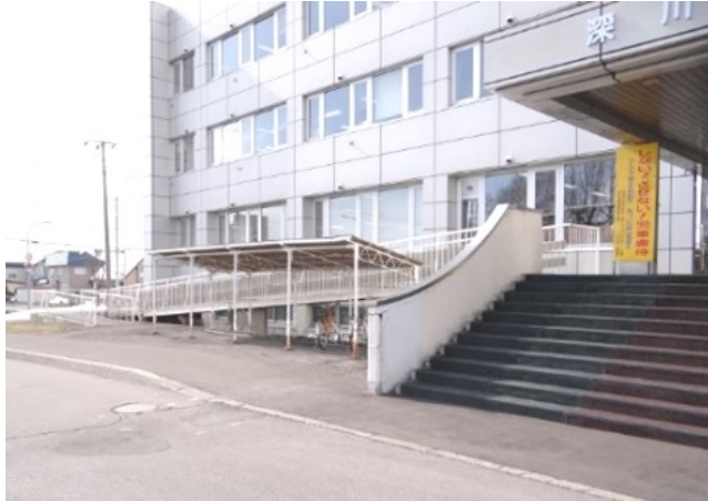
正面玄関階段と車いす用スロープ
