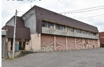
克雪車両センター
