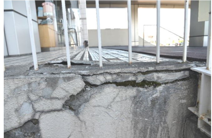
正面玄関の床部分
