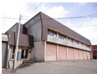
克雪車両センター
