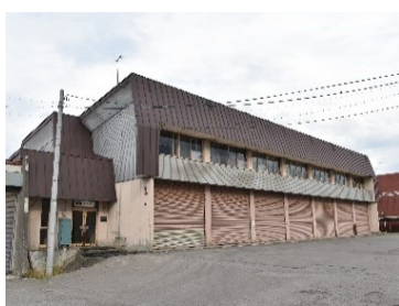
克雪車両センター
