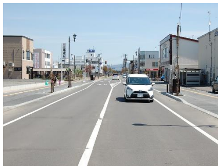
無電柱化・バリアフリー化事業
