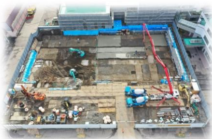
新庁舎建設工事の様子
