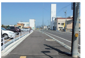
無電柱化された市道蓬萊通線
