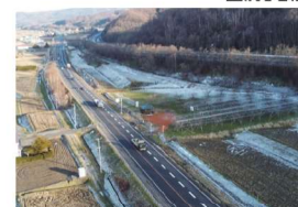
国道12号の道路改良状況（一部車線の増）
