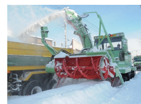
除排雪作業の様子
