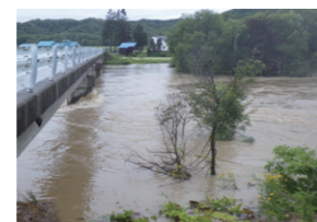
令和5年8月の大雨による河川の増水
