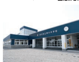
改築された深川中学校
