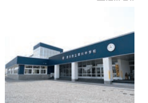
改築された深川中学校
