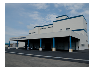
広域小麦・大豆乾燥調整 貯蔵施設
