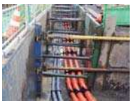
無電柱化工事の様子
