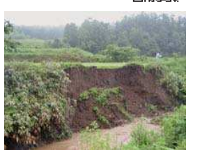
河川の被災状況
