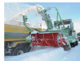
除雪作業の様子
